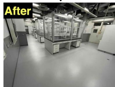
実験室の改装工事の様子 (2023年12月)
